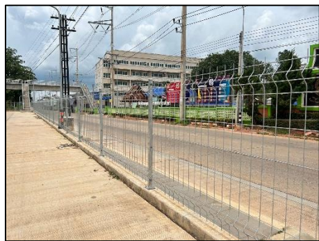
รูปที่ 2-2 การติดตั้งรั้วแนวเขตพื้นที่ก่อสร้างในโครงการ
