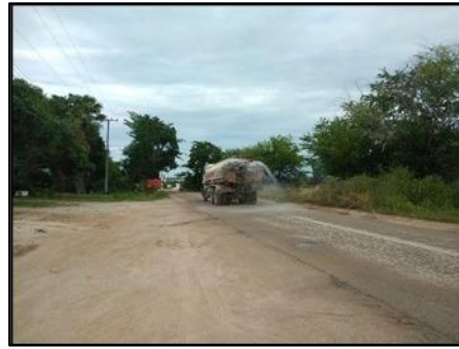
รูปที่ 2-12 การฉีดพรมน้ำบริเวณพื้นที่ก่อสร้าง
