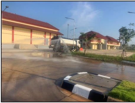
รูปที่ 2-12 การฉีดพรมน้ำบริเวณพื้นที่ก่อสร้าง
