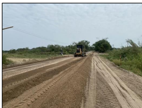
รูปที่ 2-3 การบดอัดชั้นดินบริเวณพื้นที่ก่อสร้าง
