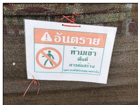
รูปที่ 2-22 การกั้นพื้นที่เขตก่อสร้าง การติดตั้งป้ายเตือน และสัญญาณไฟ
