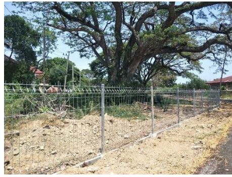
รูปที่ 2-2 (ต่อ) การติดตั้งรั้วแนวเขตพื้นที่ก่อสร้างในโครงการ
