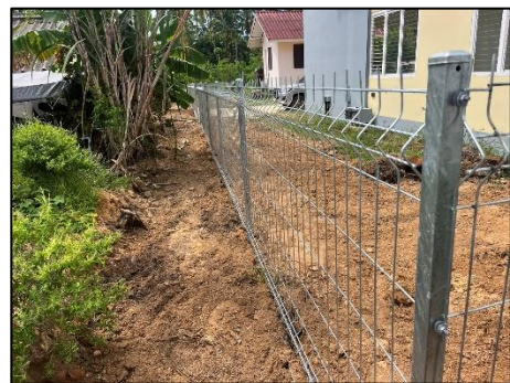
รูปที่ 2-2 การติดตั้งรั้วแนวเขตพื้นที่ก่อสร้างในโครงการ
